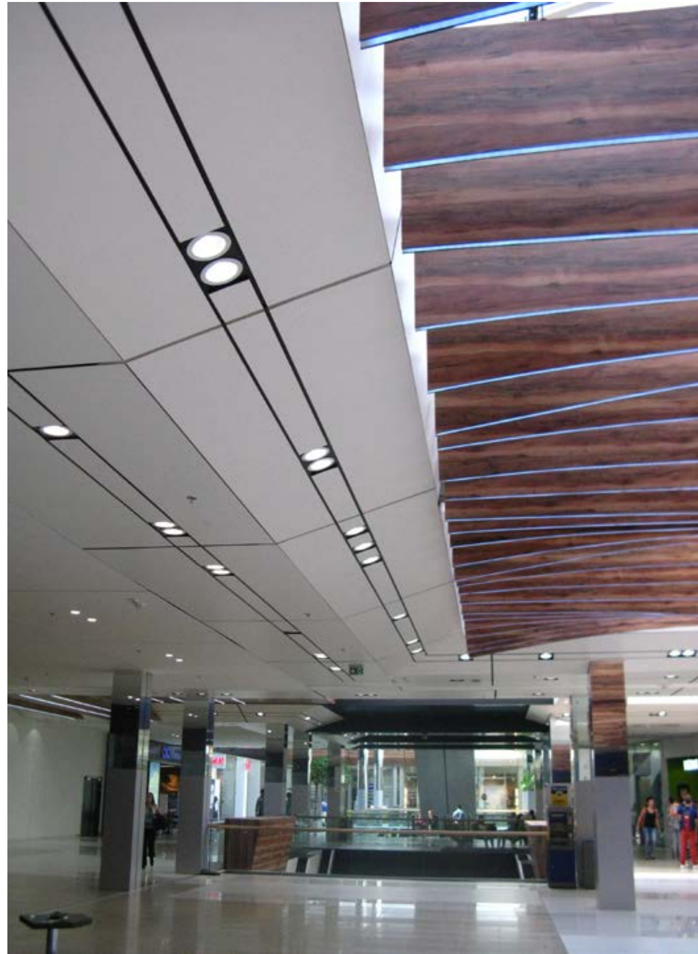
CENTRO COMERCIAL CITY ARENA (ESLOVAQUIA) - ARQUITECTO: ING. ADAMEC PAVOL | ADAMEC & ADAMEC, S.R.O. - 2715 NATURAL APPLE TREE , 0085 WHITE , 0080 BLACK
