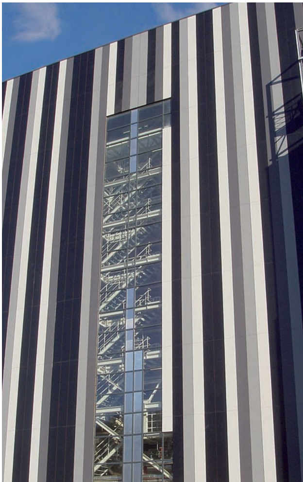
Estación de calefacción a distancia de energía ecológica St. Veit/Glan
